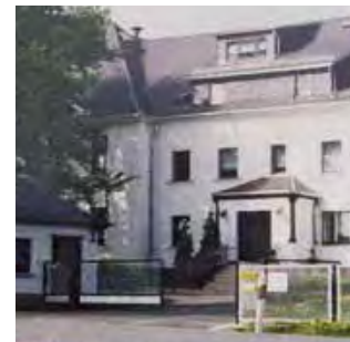
(l.o.) Grundsteinlegung, Wohnheimneubau Stelzen (Juli 1997); (l.u.) Haus „Kastanie“, Haus „Linde“, Wohnstätte Stelzen (Einweihung 1998); (r.) Haus „Buche“, Wohnstätte Stelzen
